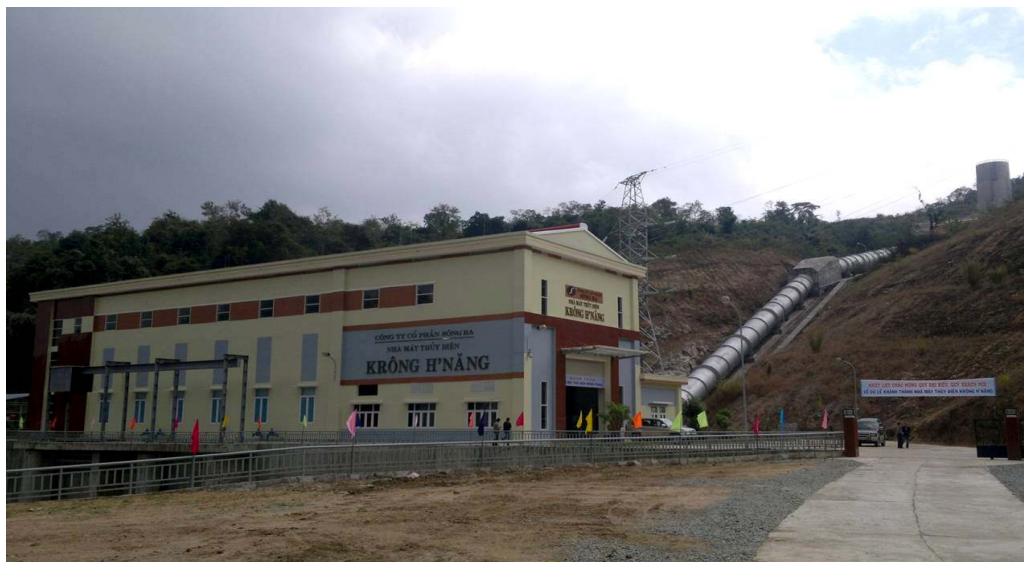
Nhà máy thủy điện Krông H'Năng (64 MW)
